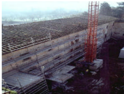
Recupero del Castello dell'Acciaio, Comune di Scandicci. Misura 2.6.1.
